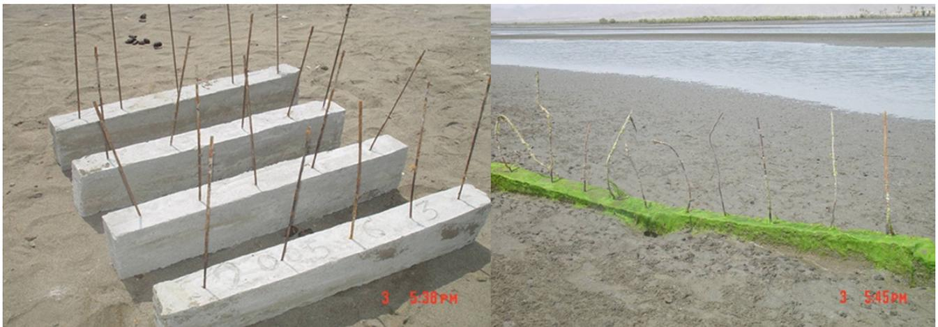
図3 鉄の棒が突き出したコンクリートブロック。最終的な設置場所において、陸地側に土壌を堆積する。
